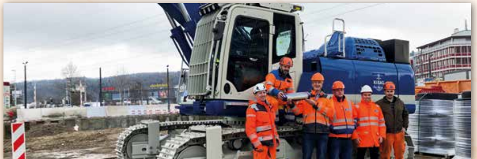
PC390-11E0 High Reach Demolition (57 to Betriebsgewicht, 26 Meter Reichhöhe)
