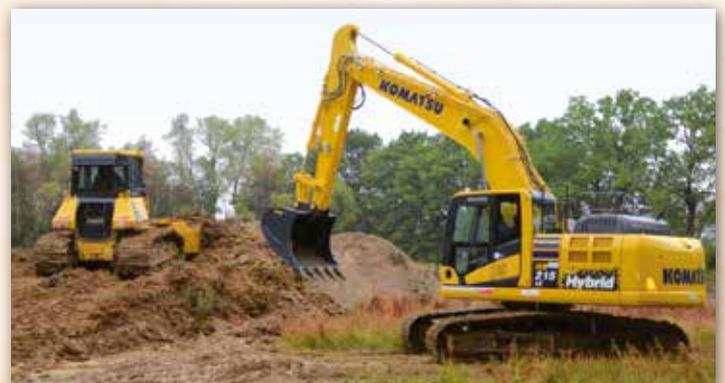
*Bulldozer D51PX-22 in der Ausführung mit breiteren Raupen und Bagger Komatsu mit einem Hybridantrieb und Bezeichnung HB215 LC während der Arbeit im Pohán-Teich*
